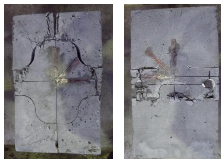
写真1 組積体の最終ひびわれ面 (左: 面内 右: 面外)
